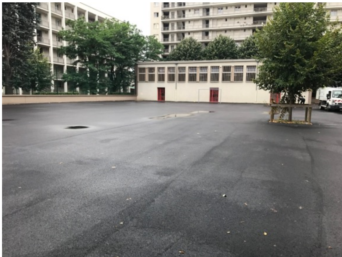
La cour avant les aménagements
